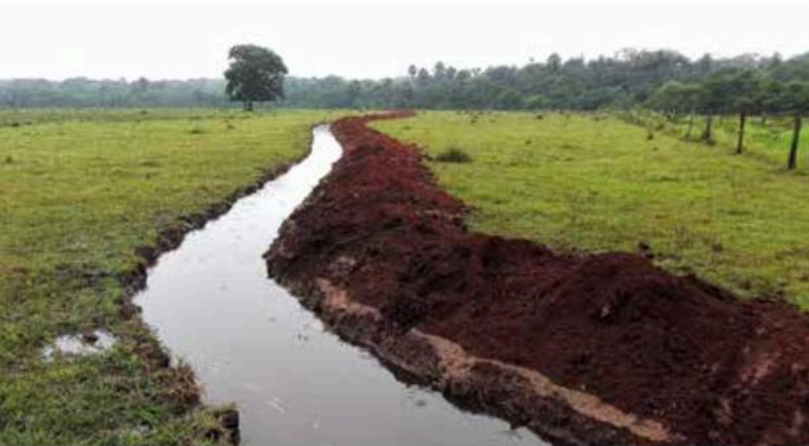
Zanjas adecuadas disminuyen la velocidad y el escurrimiento de agua.
